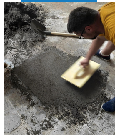
Ремонт пола: заглажи- вание поверхности
