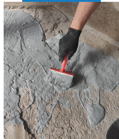
Ремонт пола: нанесение адгезионной растворной смеси
