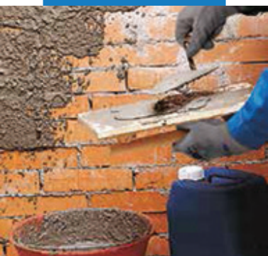
Набрызг адгезионной растворной смеси с добавлением Admix P
