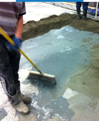
Нанесение адгезионной растворной смеси с добавлением Admix P
