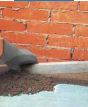
Укладка цементной стяжки на адгезионную растворную смесь с добавлением Admix P
