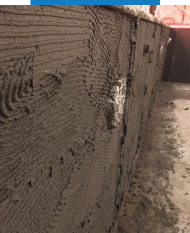
Адгезионная растворная смесь с добавлением Admix P, нанесенная зубчатым шпателем
